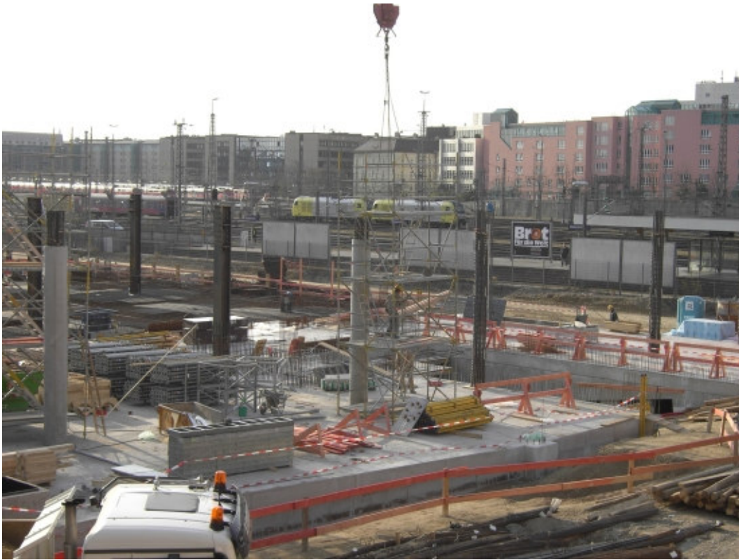
Blick von der Hackerbrücke über die Gleistrasse (März 2008)
