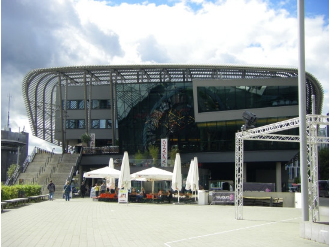
Die der Innenstadt zugewandte Front des ZOB mit breiter Freitreppe zur Ladenpassage (September 2011)
