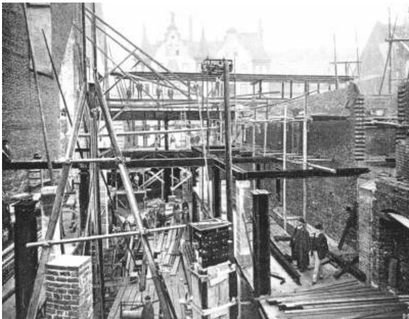
Verwendung von Eisenkonstruktionen der Firma Spaeth beim Hausbau in Nürnberg um die Jahrhundertwende
