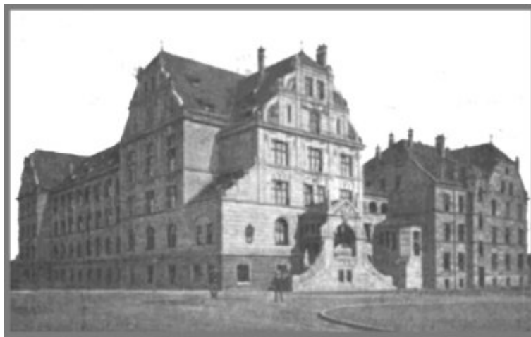
Das Technikum Nürnberg, Keßlerstraße 40
