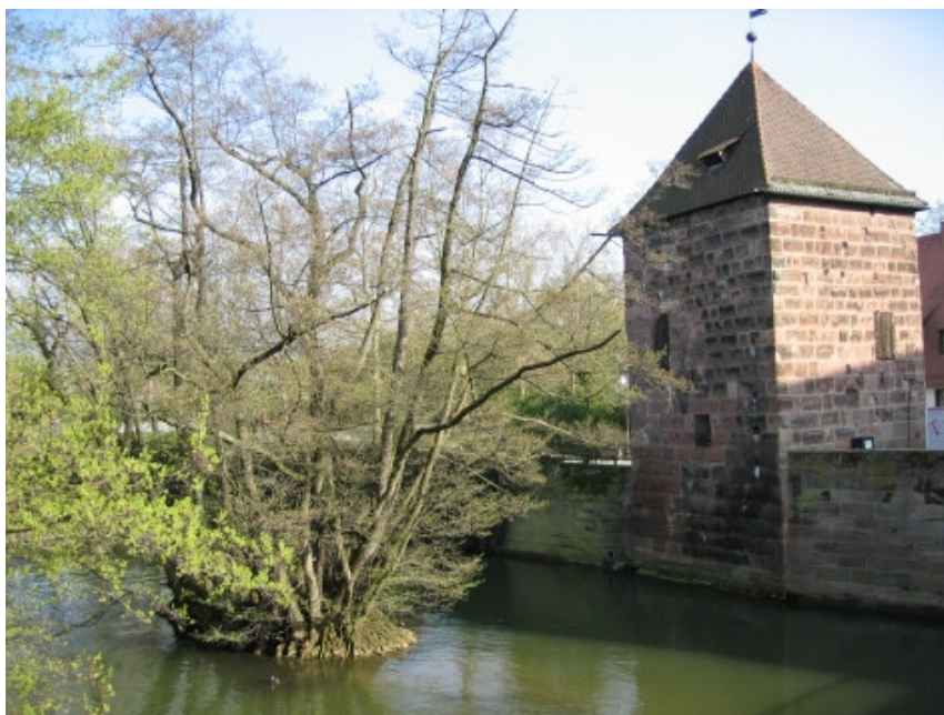
Der „Fraueneisen“ genannte Turm von der Flussseite gesehen (Foto: rijo)
