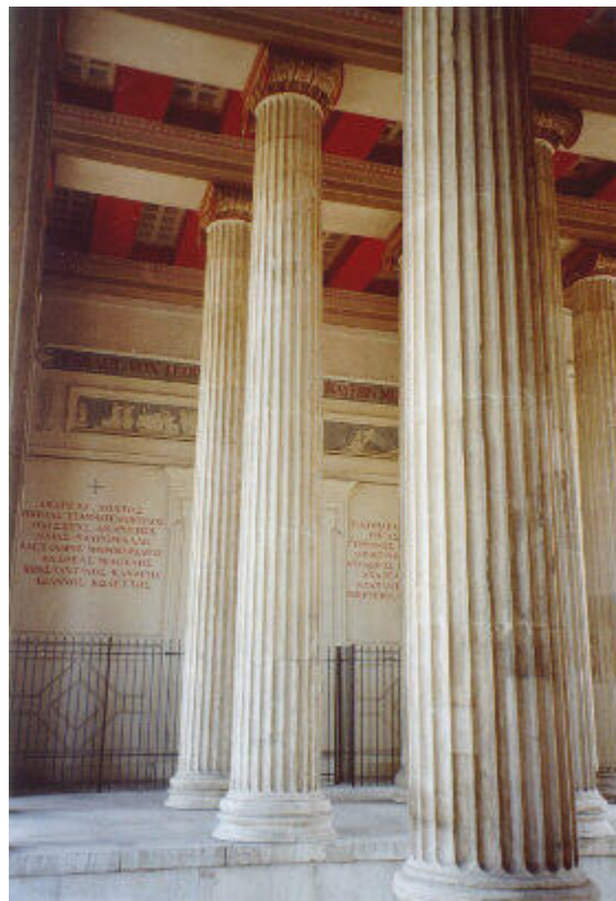
Das Innere der mittleren Durchfahrt
